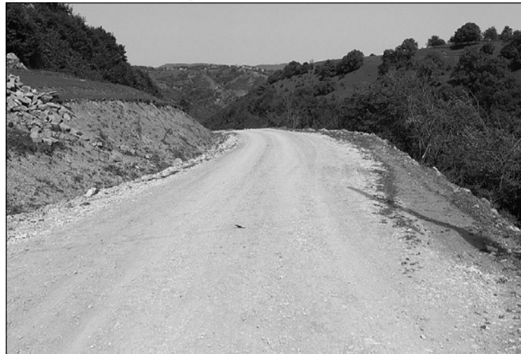
(Дорога в село Урзиг после ремонта.)
