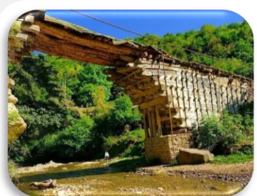
ШИЛЕНСКИЙ ДЕРЕВЯННЫЙ МОСТ
