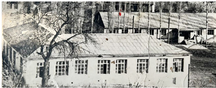
Вид старого здания школы.
