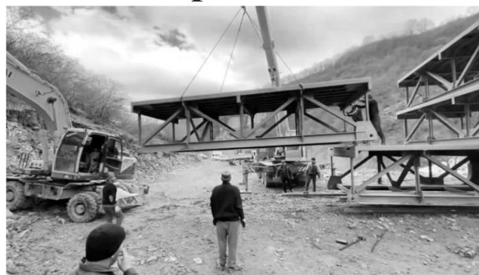
основание местонахождения будущего моста, устроены кюветы и насыпи. Уже летом была проведена заливка опор моста. Согласно регламентам, после этого этапа работ до укладки пролетов должно пройти определенное время для усадки основания. Поэтому к укладке пролетов приступили только сейчас.
